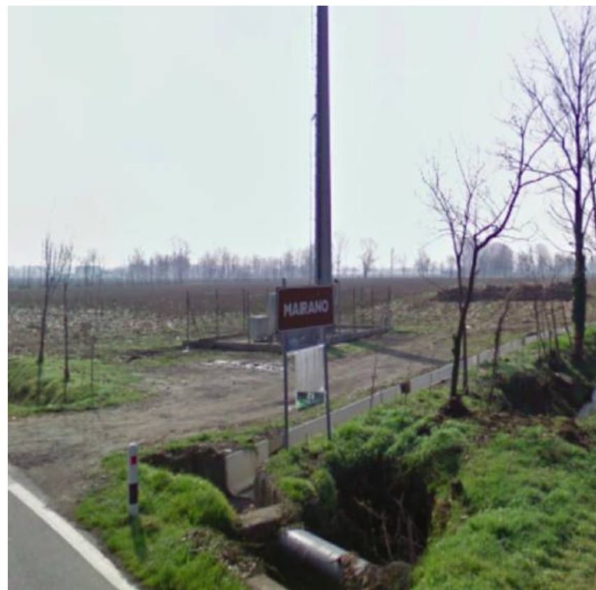
Il depuratore di Mairano
